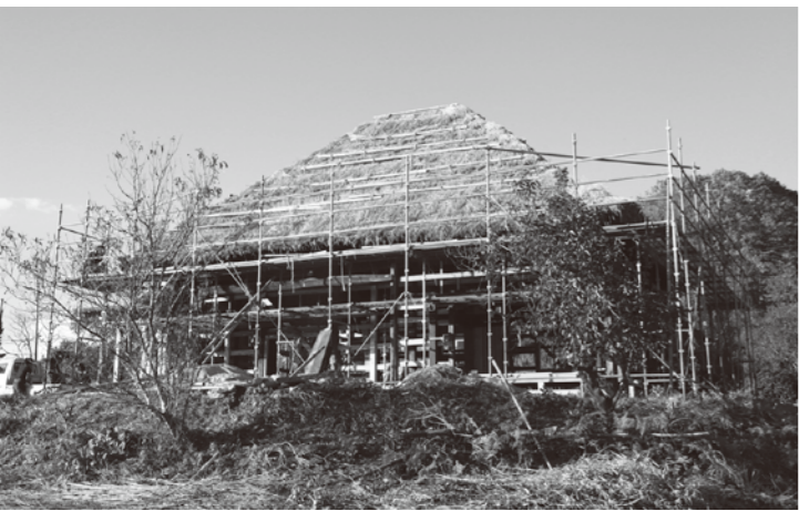
屋根葺き途中の茅葺き小屋全景
