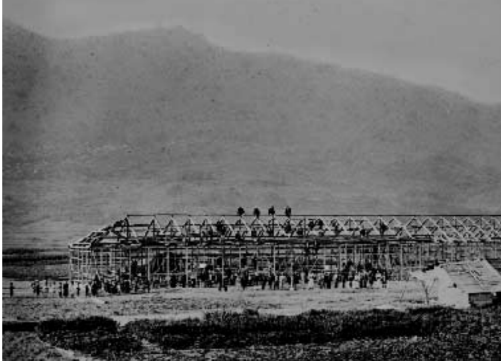
田井小学校上棟式（大正7年）
